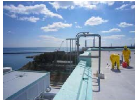
図3 ベントホール穿孔作業(参考資料7より)
